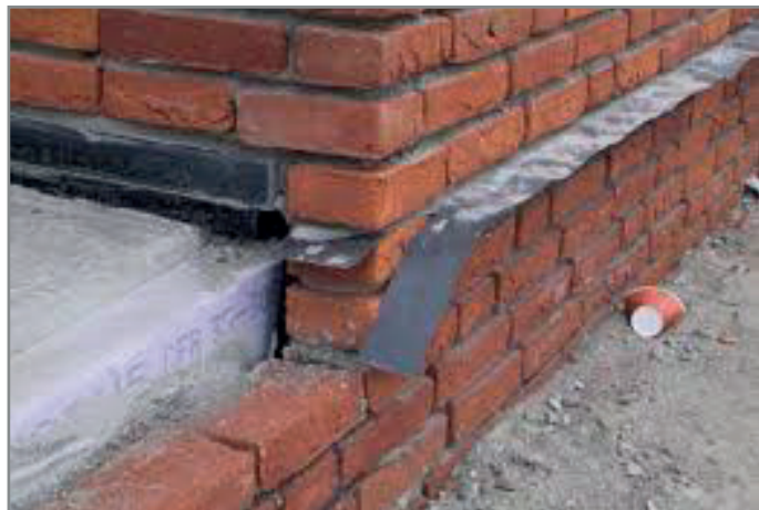
Afbeelding 2: DPC folie net boven maaiveld (©knb-keramiek)
